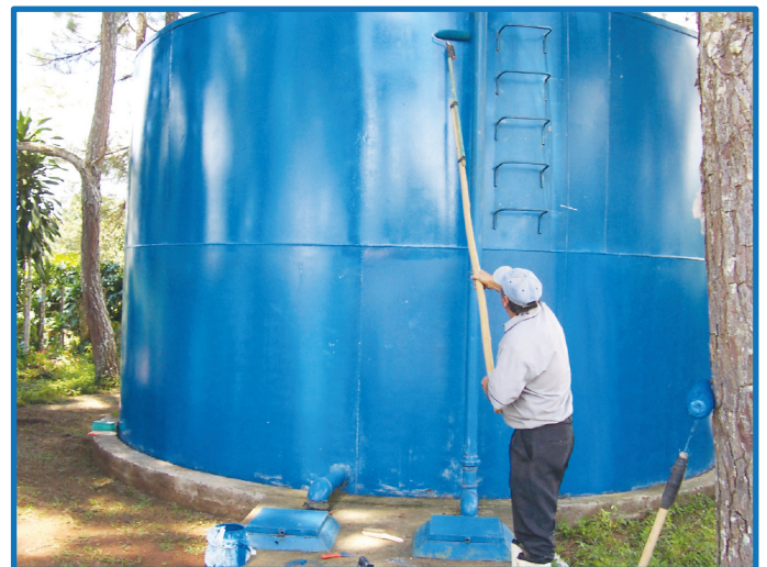
Fotografías del mantenimiento de redes y tanques del Acueducto de San Pedro de Pérez Zeledón, Acueducto Galardonado con la Bandera Blanca del Sello de Calidad Sanitaria.
