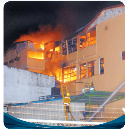
Incendio en el Hospital Calderón Guardia. Tomado de www.ccss.sa.cr 12/07/2005.
