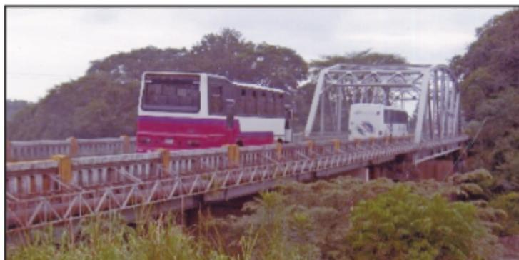
Puente sobre el río Barranca. Nótese la tubería al lado izquierdo de puente que conduce agua desde los Pozos de Pocamar hacia la planta de tratamiento
