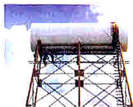
Tanque de almacenamiento metálico elevado, acueducto Guápiles y Guácimo
