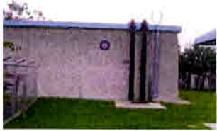
Tanque Jordán, Guápiles
