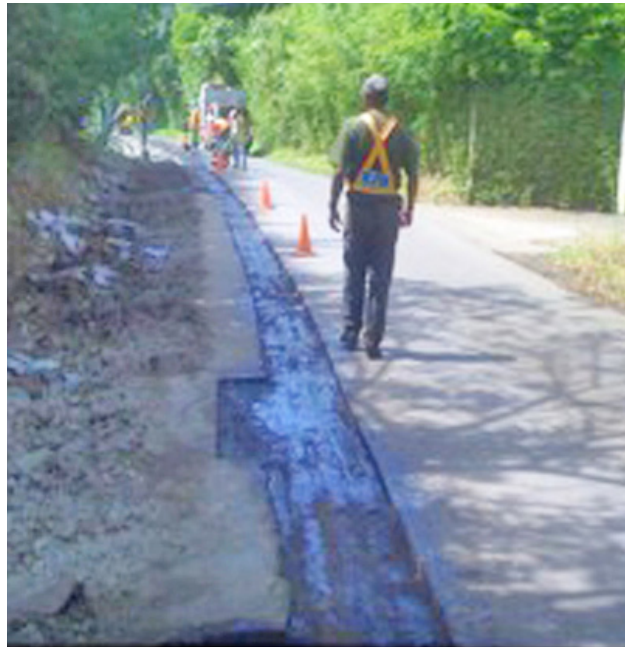
Figura No. 13. Reposición carpeta asfáltica
