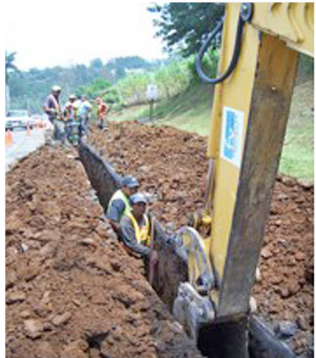
Figura No. 12. Colocación de tubería
