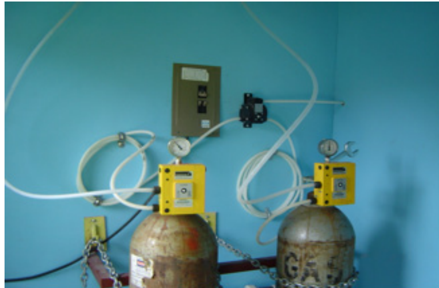
Figura #2. Cloro gas por solución al vacío. Tanque Jordan, Región Huetar Atlántica.
