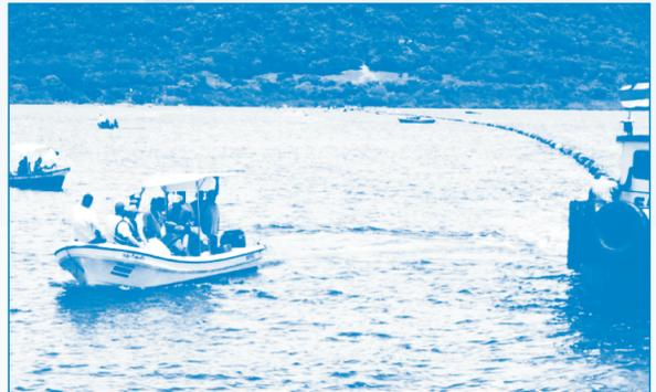
En este punto se había alcanzado la posición deseada. Nótese que la tubería estaba recta y el mar estaba calmo, pues se estaba muy cerca de la marea cero
