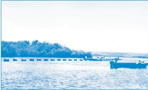
Iniciaba el remolque de la tubería, con los remolcadores y las pangas de los isleños
