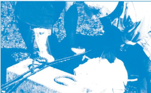
Colocando el sistema para halar la tubería
