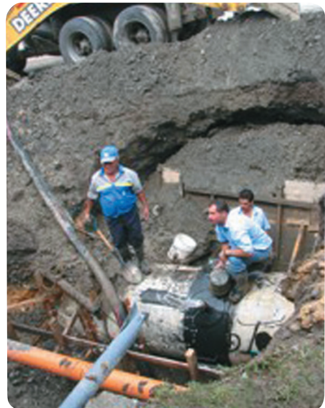
Foto 3. Línea de conducción Proyecto Orosi. Foto Jorge Soto.
